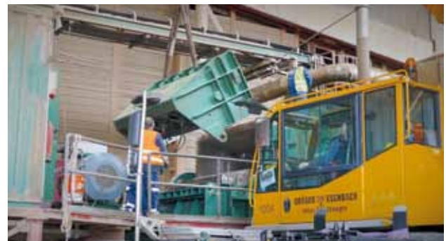
Oben: Modernisierungsmaßnahmen an einer Prallhammermühle
